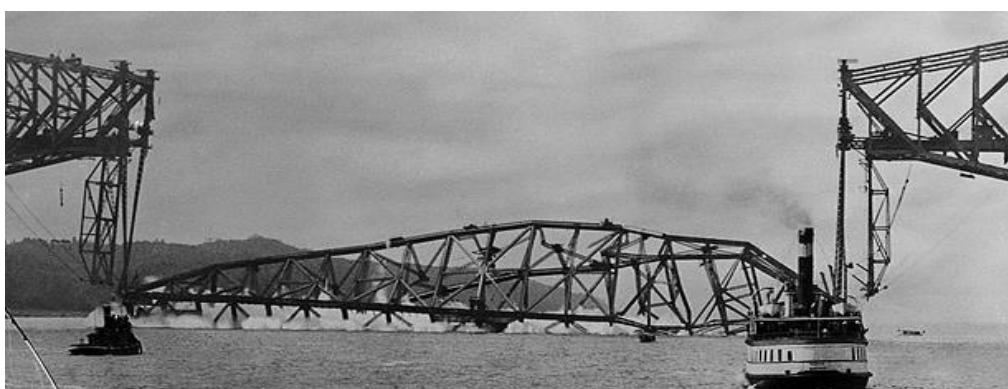
Slika 4 – Most u Quebecu, rušenje centralnog segmenta, 1916. [7]
