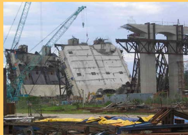
Can Tho Bridge, Vijetnam Izvijanje dijela presjeka tijekom izgradnje. Istraga još traje. 2007. 60 poginulih.
