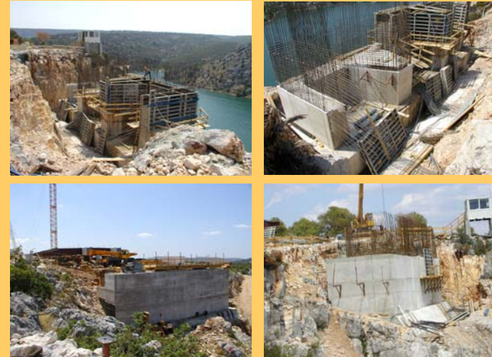
Izvedba upornjaka za most Krka
