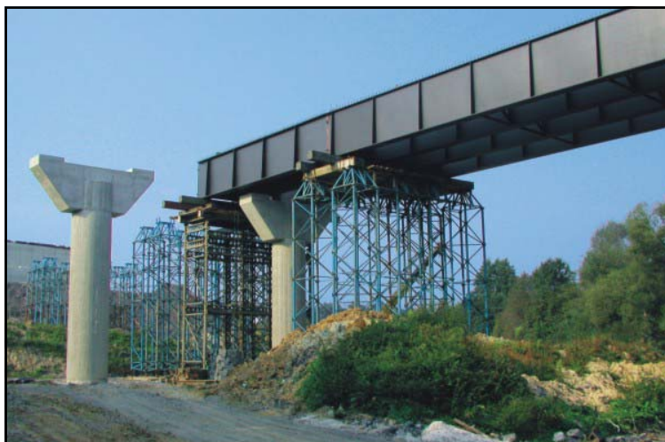
Montiranje glavnih nosača grednog mosta preko privremene čelične skele
