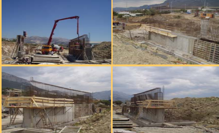
Izvedba upornjaka za nadvožnjak Mercatone, Kaštel Sućurac
