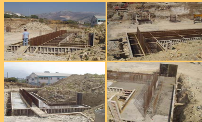
Izvedba temelja upornjaka za nadvožnjak Mercatone, Kaštel Sućurac
