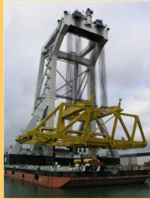
Montiranje rasponskog nosača mosta Øresund plovnom dizalicom
