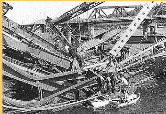
Second Narrows Bridge, Vancouver, Kanada Uzrok rušenja je greška u proračunu glavnih nosivih elemenata, 1958. 19 poginulih i 79 ozlijeđenih. Nanovo izgrađen.
