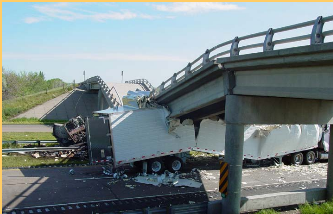
Big Springs, Nevada, USA Vozač kamiona je izgubio kontrolu nad vozilom, te se zabio u stup nadvoznjaka. 2003.
