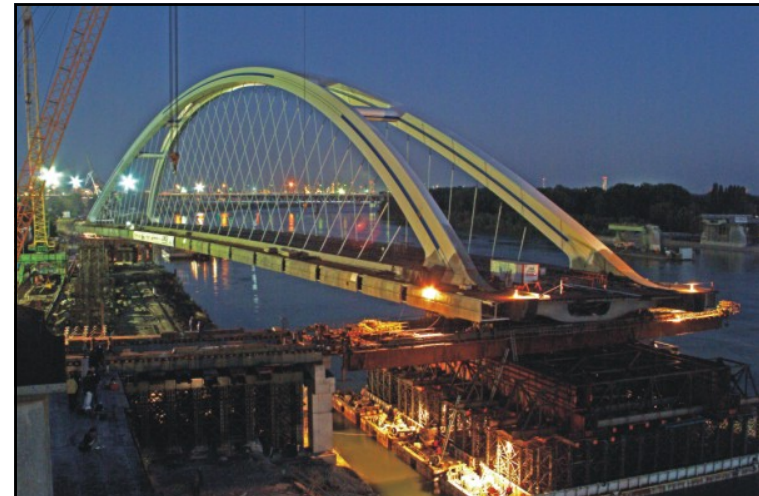
Montiranje kompletnog rasponskog sustava nekog mosta
