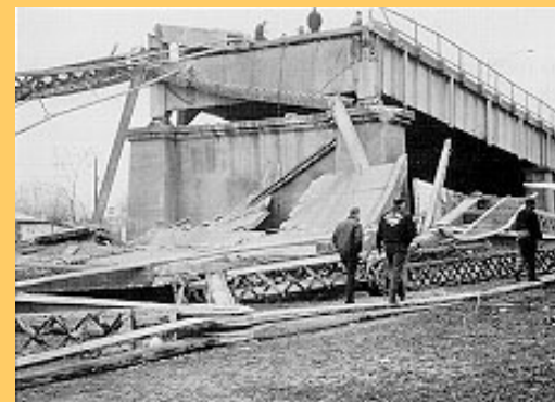
Silver Bridge, između: Point Pleasant, West Virginia i Kanauga, Ohio, USA Uzrok rušenja je greška u materijalu i korozija, 1967. 46 poginulih i 9 ozlijeđenih. Inspirirao knjigu i film: "Mothmanovo proročanstvo"
