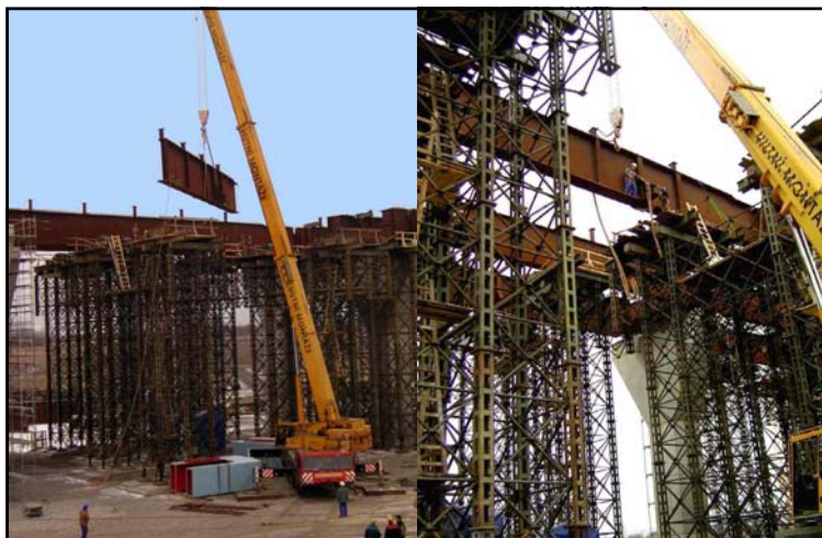
Montiranje rasponskog sustava nekog čeličnog grednog mosta s pomoću dizalica – kratki segmenti montiraju se na pomoćnu skelu
