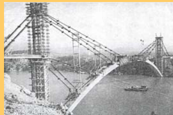
Konzolni postupak s kosim zategama primijenjen na Šibenskom mostu
