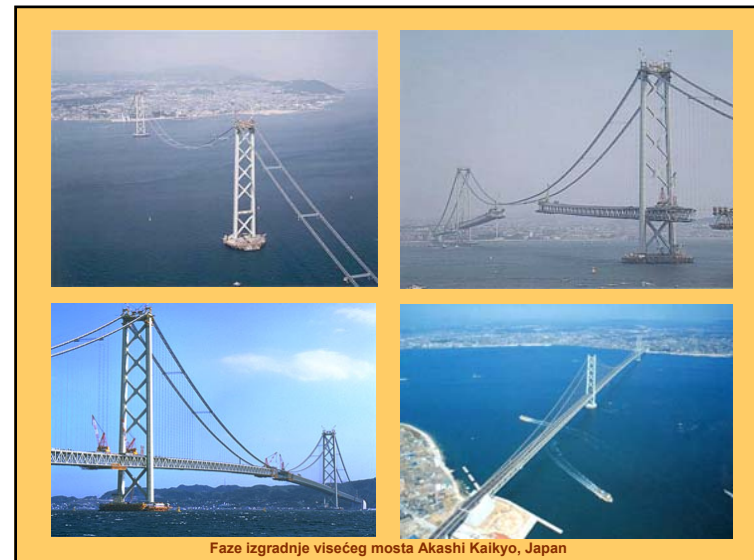
Faze izgradnje visećeg mosta Akashi Kaikyo, Japan
