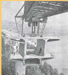
Postavljanje konzolnog sklopa uz pomoć derrick dizalice
