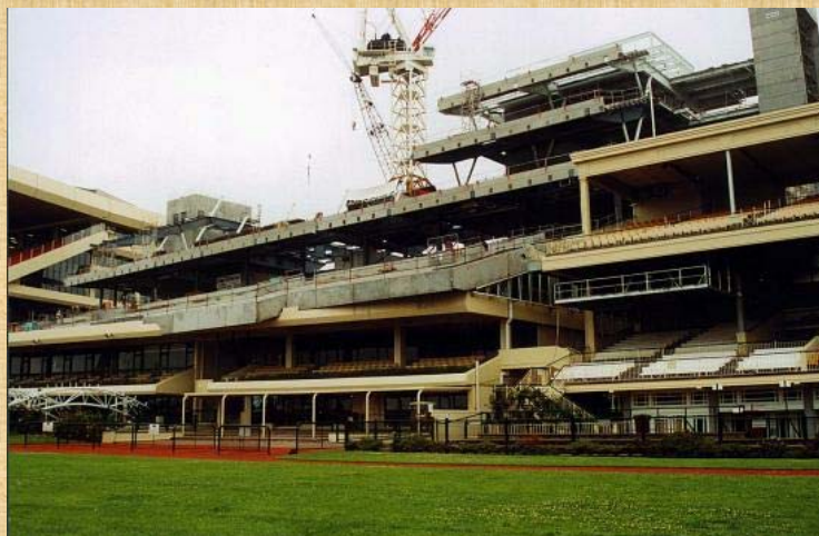
Montažna gradnja tribina stadiona
