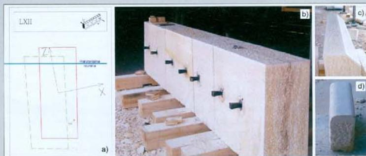
Slika 11. a) Označavanje reda luka za klesanje, b) Isklesani red luka s ugradenim željeznim klinovima, c) isklesani element vijenca, d) Obradjeni element praga kamene kaldrme
