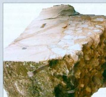
Slika 10. Konstruktivno podebljivanje pete luke ispod štednih otvora
