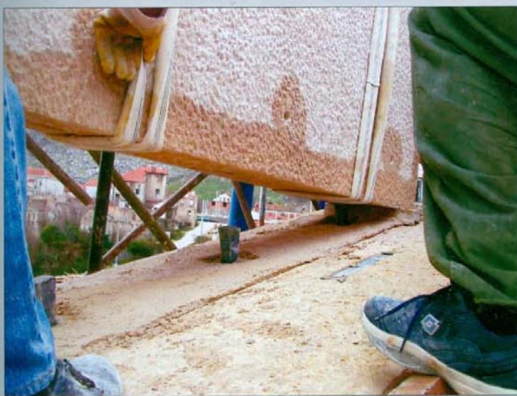
Slika 12. Montaža teškog kamenog bloka ograde (korkaluka)
