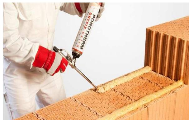
Zidanje POROTHERM PROFIL zidnih blokova ljepilom (poliuretanskom pjenom) DRYFIX.EXTRA značajno povećava vlačnu čvrstoću зида (potvrđeno ispitivanjem). Zbog povećanja vlačne čvrstoće зида, posredno se povećavaju posmična i savojna čvrstoća зида, odnosno nosivost зида na poprečne sile i momente savijanja, te u konačnici - otpornost zidane građevine na djelovanje potresa.
